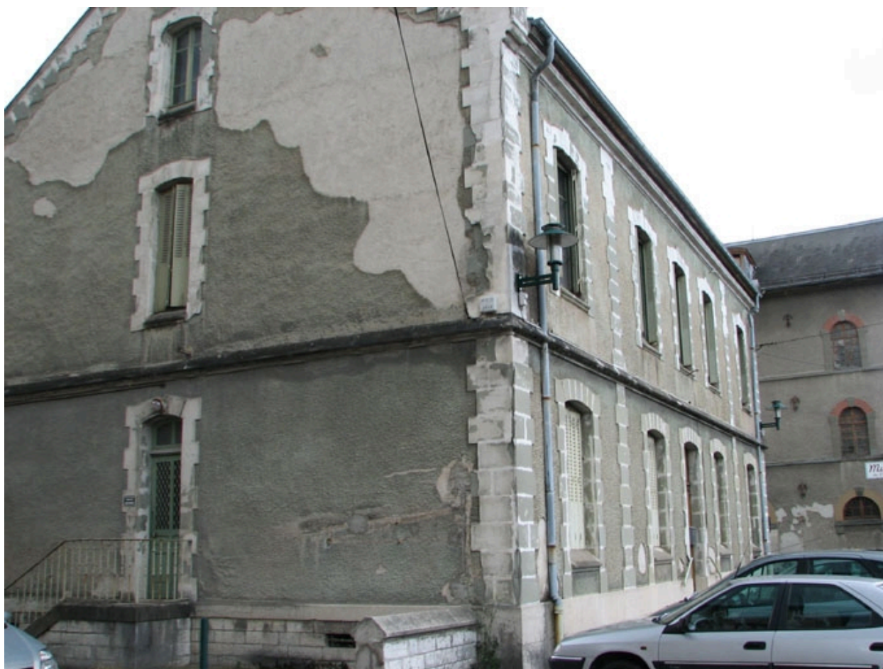
Pignon bâtiment administratif
