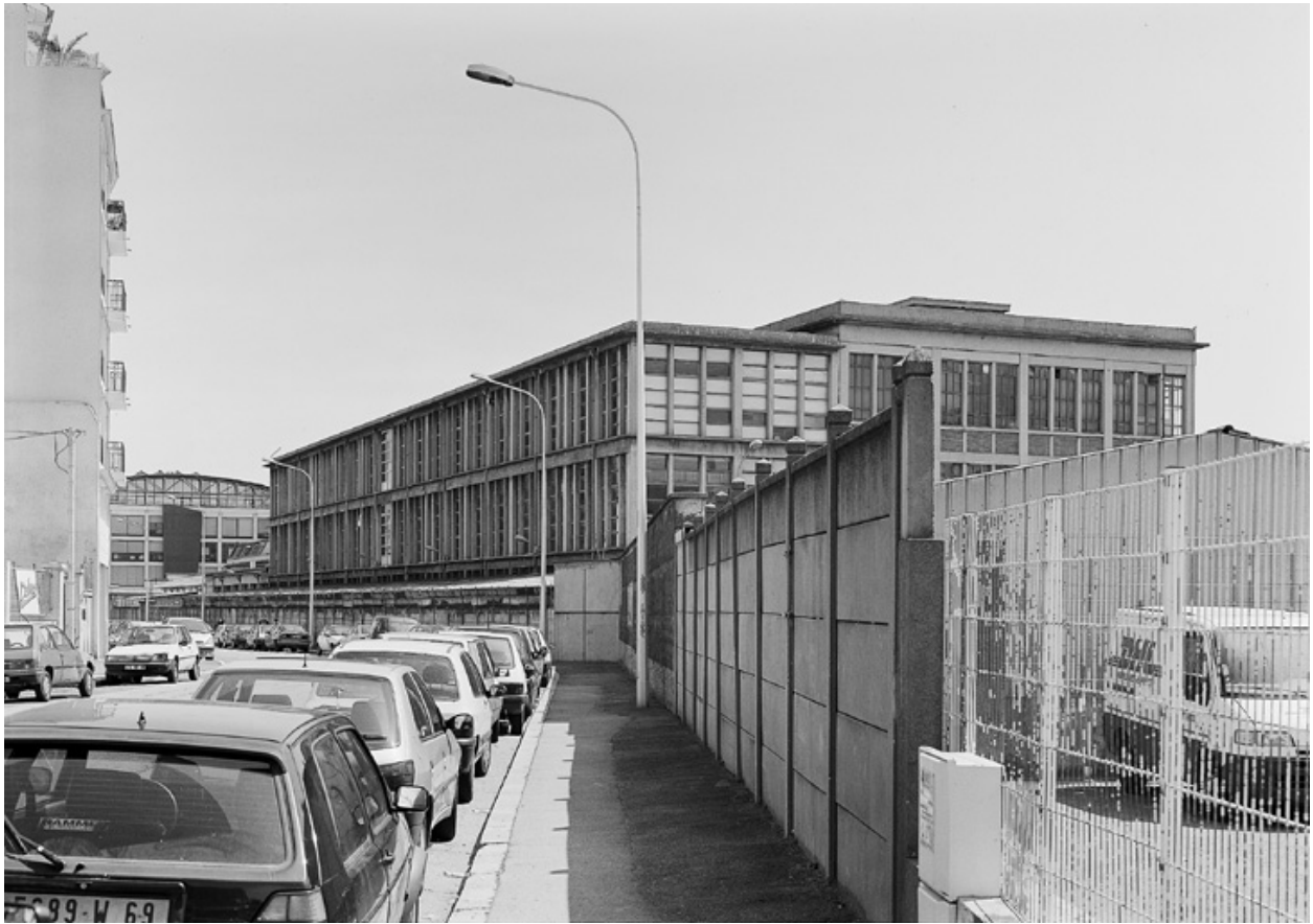
Vue d'ensemble nord-ouest du bâtiment de la rue Lortet
