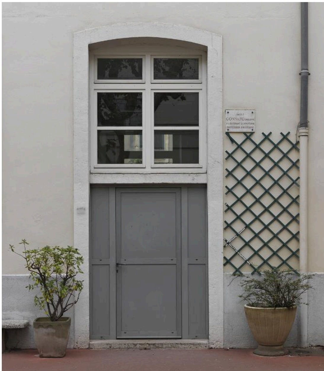
Cour d'honneur, élévation est : porte d'une classe
