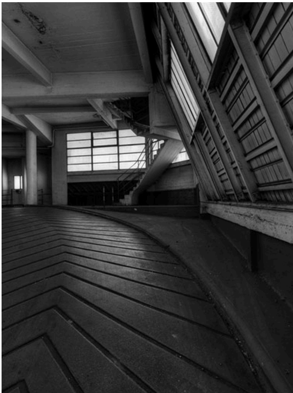
Rampe montante : toit brisé (vue intérieure)
