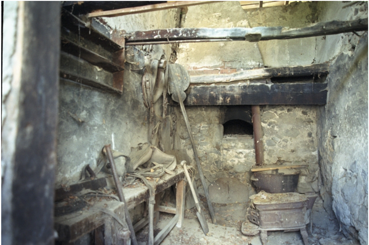
Cezay, la Chavanne (1987 A2 277), type A1. Four à pain, vue d'intérieur.
