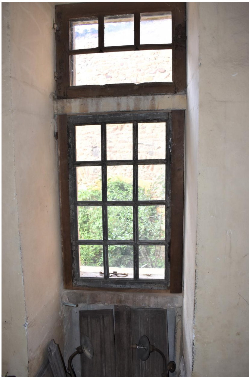
Repos de l'escalier menant à l'étage carré depuis le hall d'entrée. Vue d'ensemble de la baie éclairant l'escalier.
