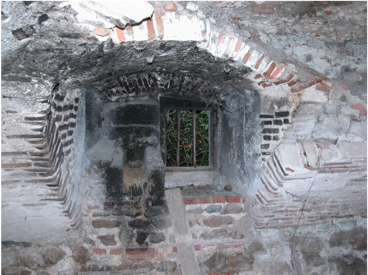
Vue intérieure du cellier : gouttière aménagée dans un jour de la troisième cave.
