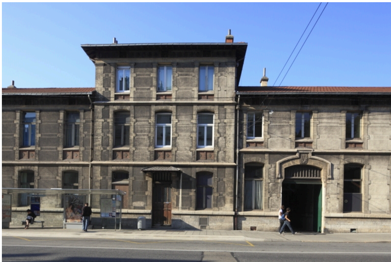
Bâtiment d'entrée sur les cuisines cours Agutte Sembat.
