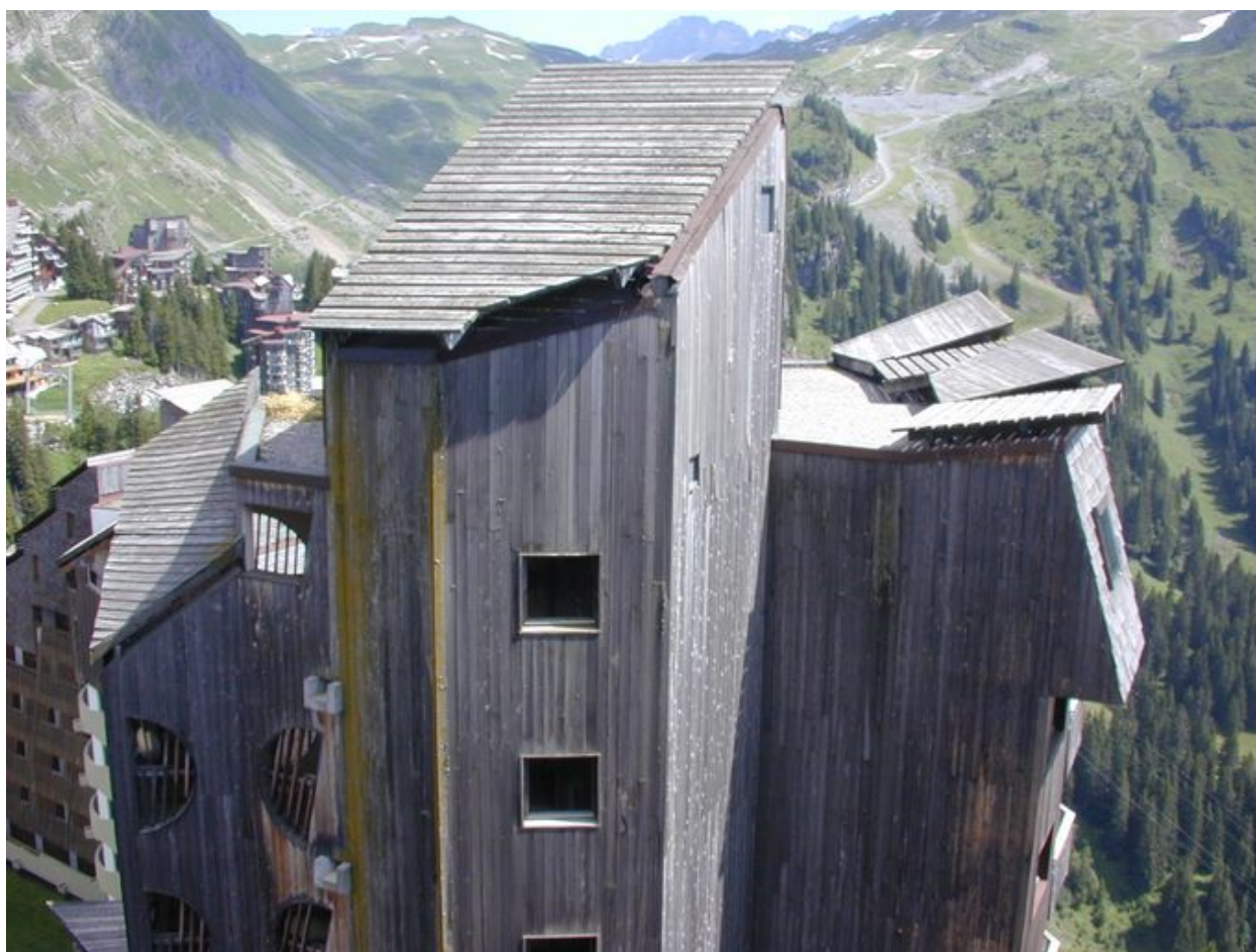
Le pignon ouest, détail de toitures
