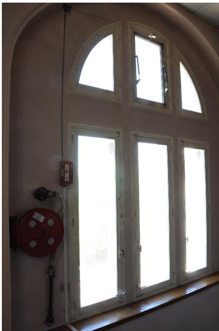
Baie éclairant la cage d'escalier
