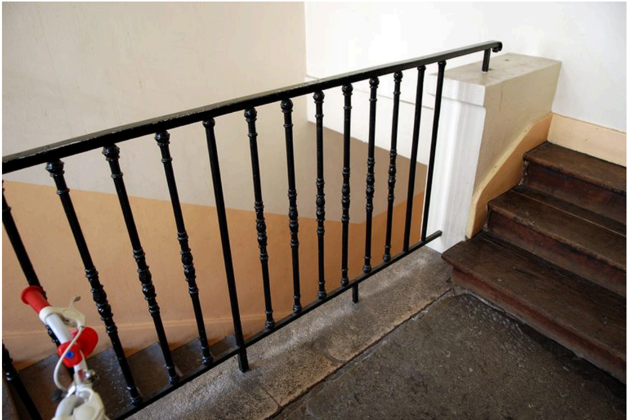
Cage d'escalier : garde-corps du dernier étage
