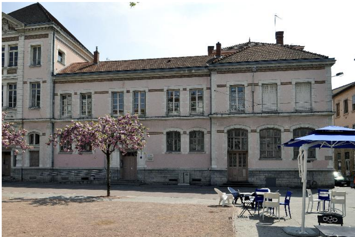
Elévation principale : détail de la partie est
