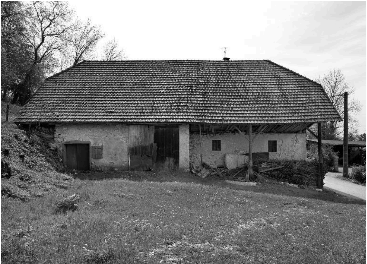
Vue d'ensemble de la façade arrière.
