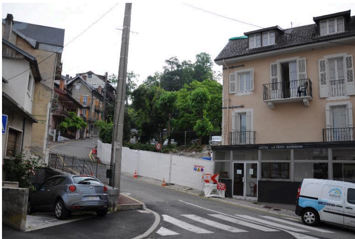
Démolition complète, juin 2015, vue prise depuis le boulevard Berthollet
