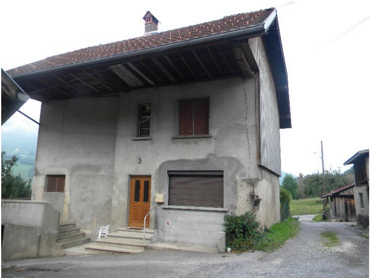
Vue d'une maison très remaniée (2008 E10 1674)
