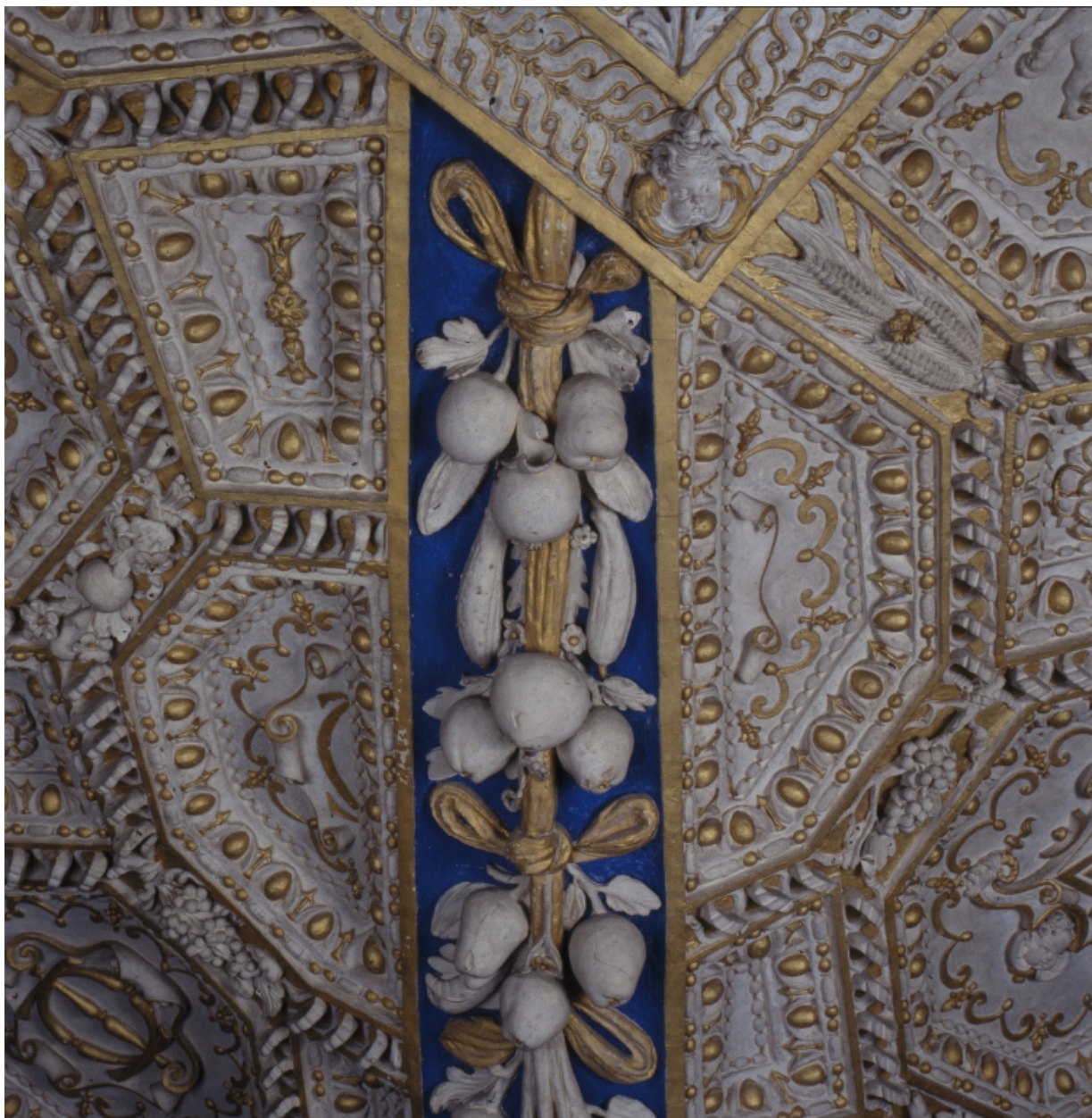
Nervure n°3, premier segment (de la clef vers la corniche) : pommes, cornichons.
