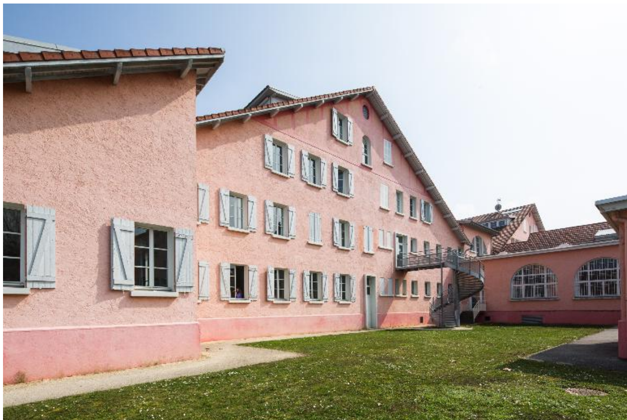
Bât. A : façade nord-ouest de l'aile est
