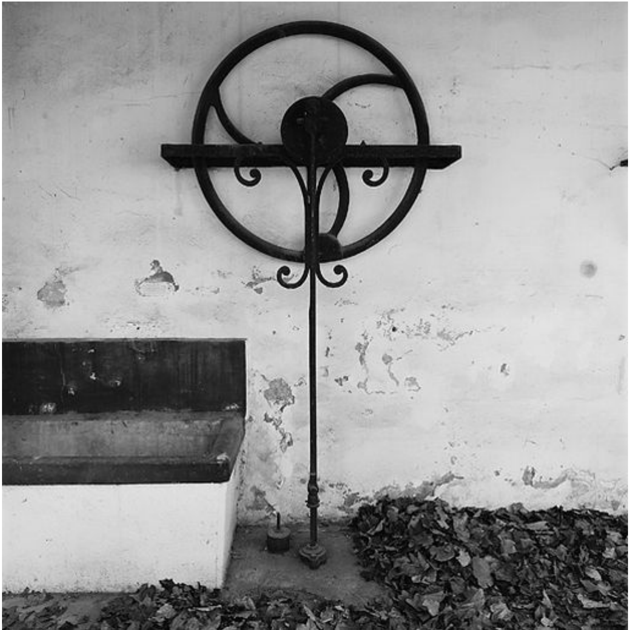
Cour attenante au logement du gardien, ouvrant 4, rue des Alouettes, pompe vue de face
