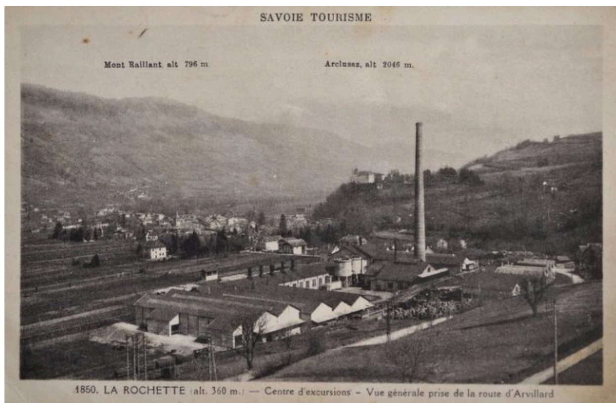
Vue des cartonneries (© Collection particulière M.-A. Podevin).
