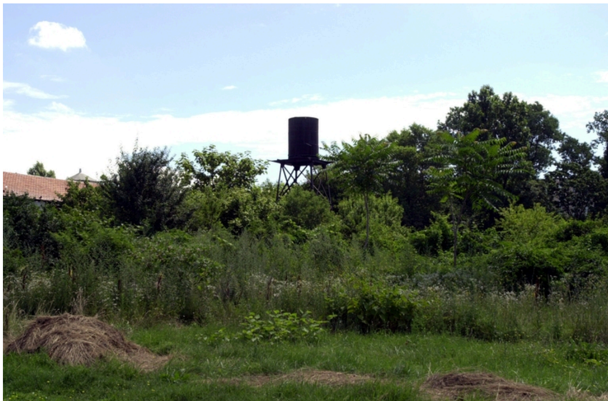
Château d'eau, vue sud-est
