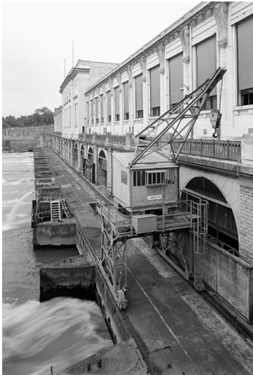
Grue et arrière-becs aval
