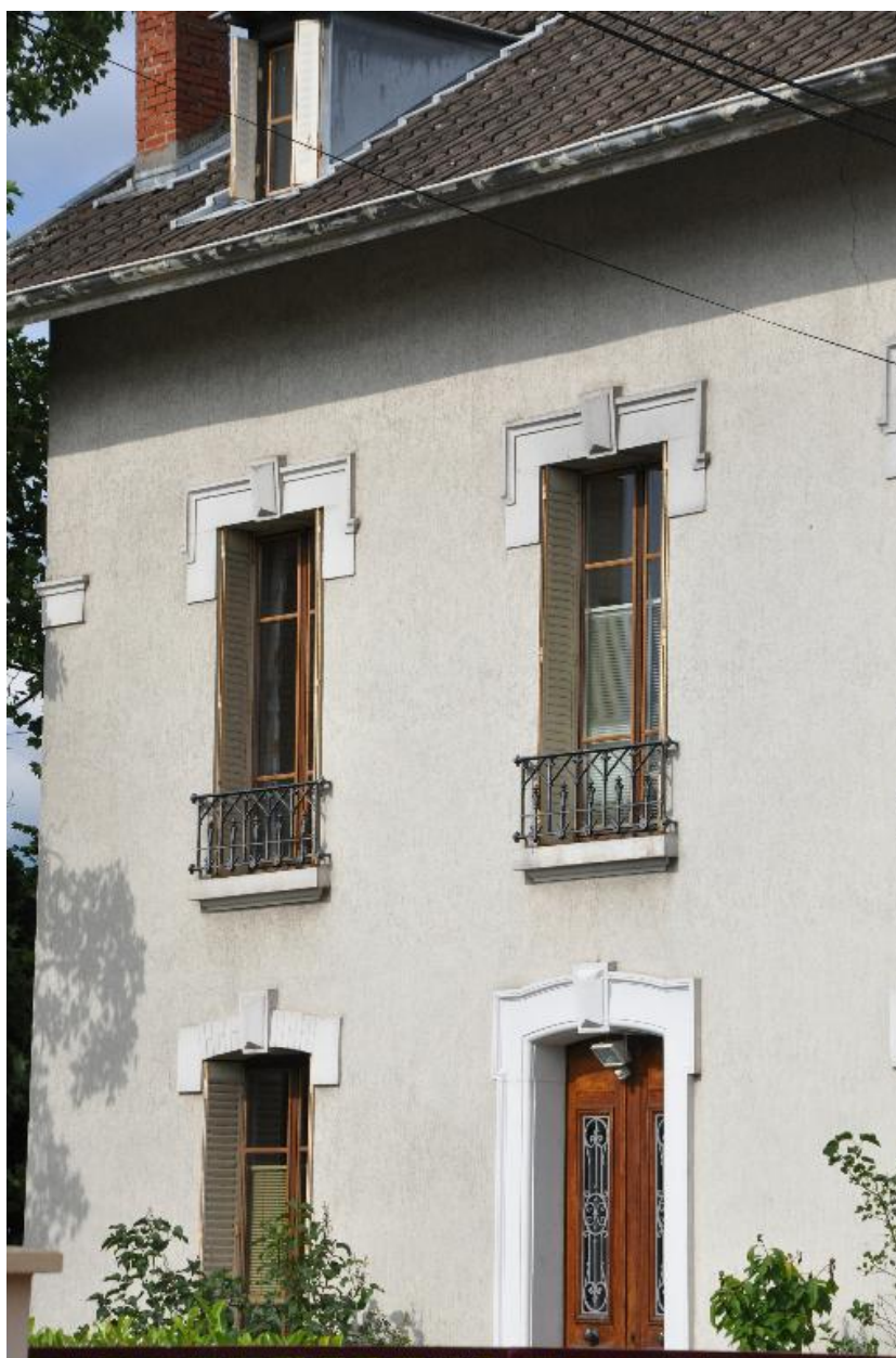
Détail des baies de l'élévation postérieure
