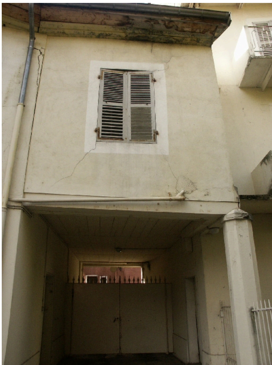
Corps de porche depuis la cour
