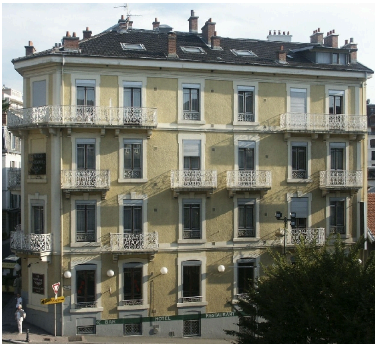
Façade sur la rue Daquin
