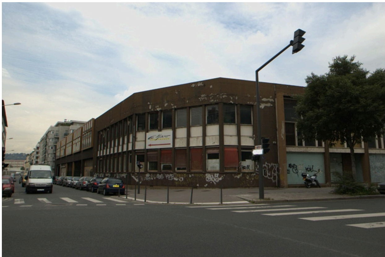
Vue d'ensemble nord-est
