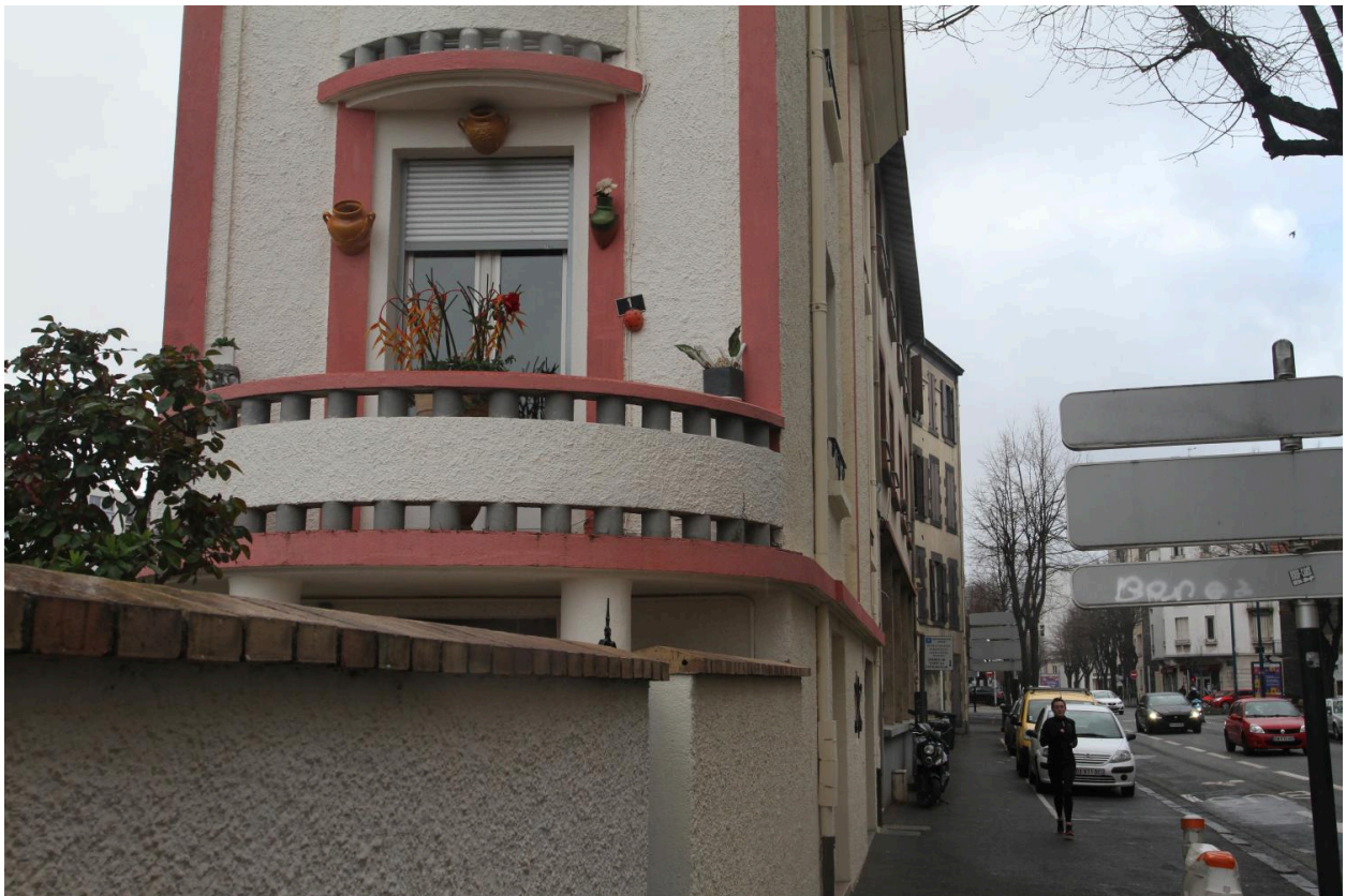
Détail de l'élévation latérale au boulevard
