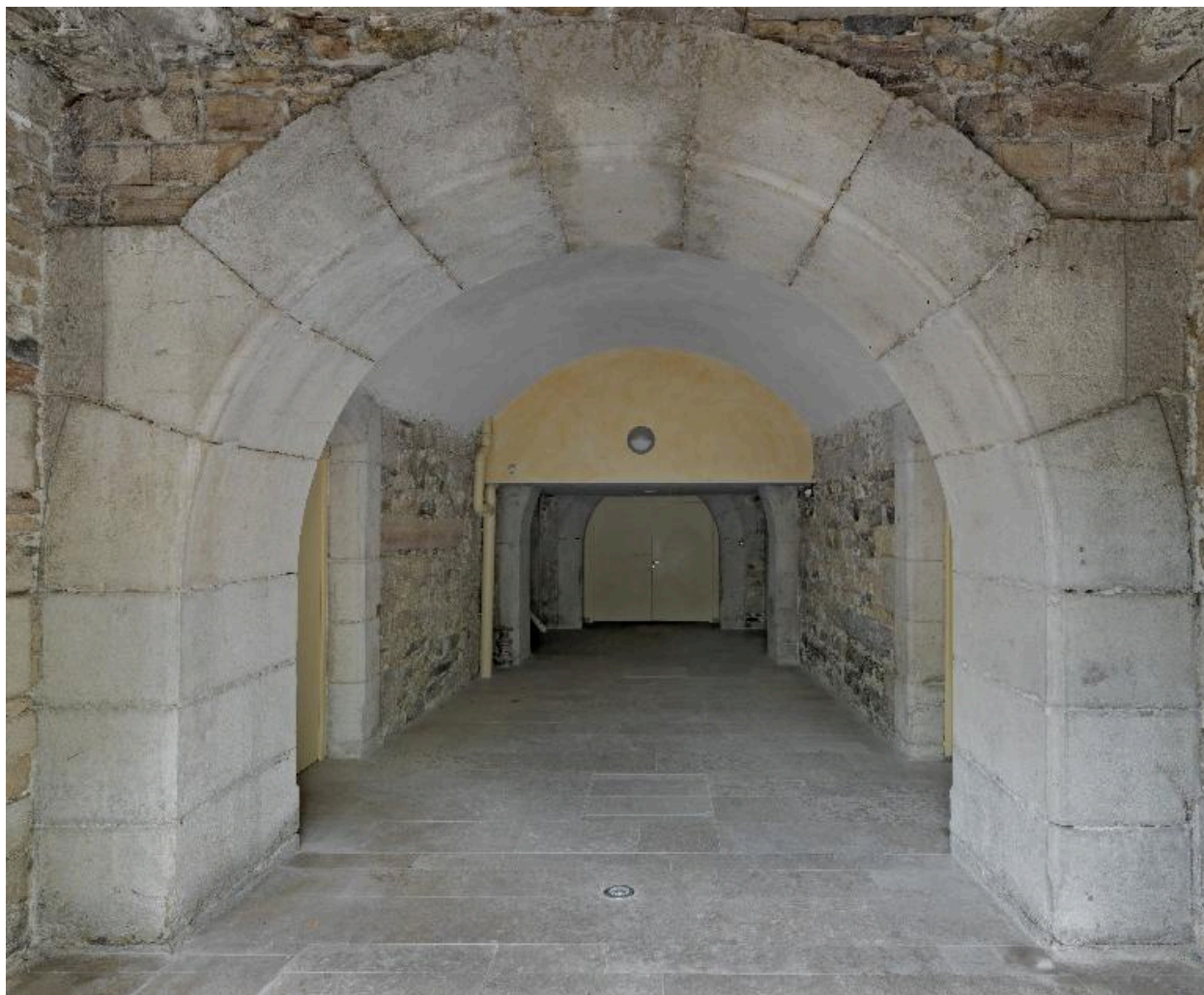
Corps de bâtiment nord-est, étage de soubassement : couloir d'accès aux caves, depuis l'entrée
