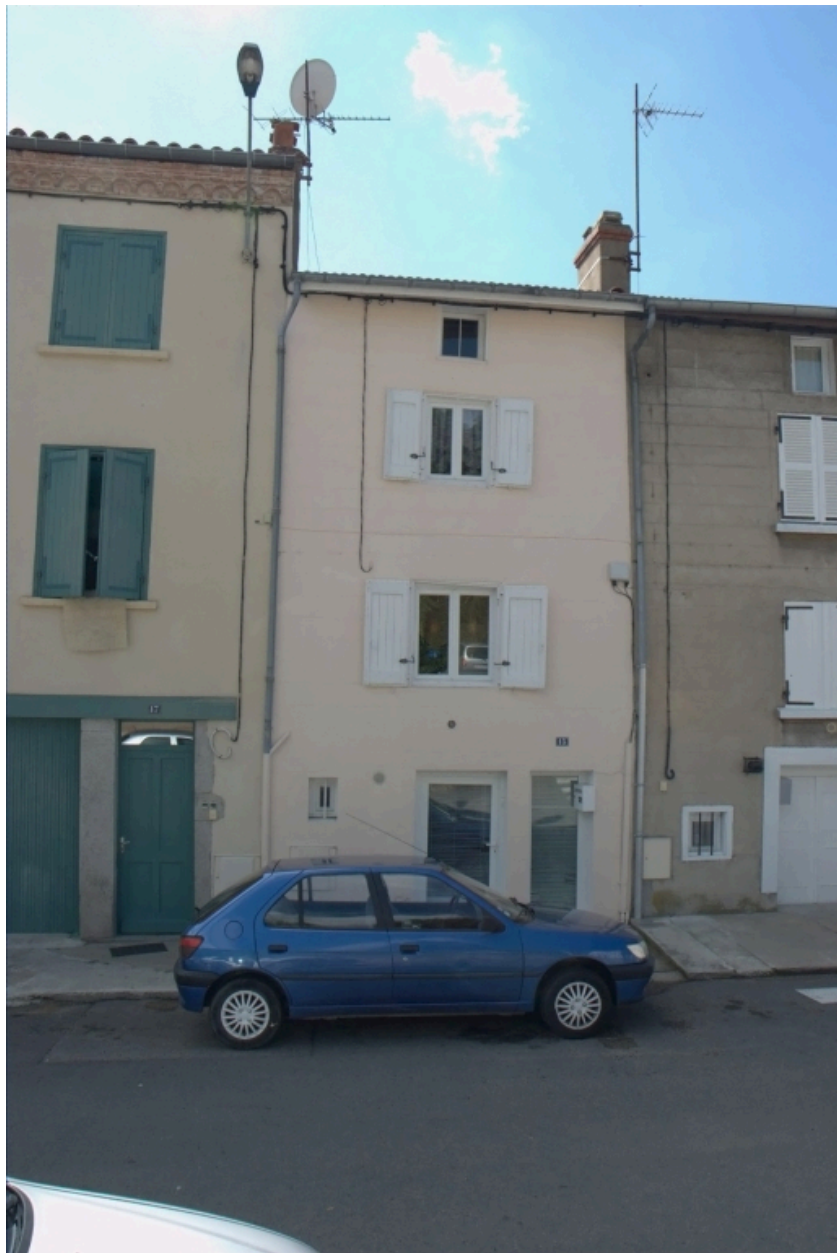
Îlot 3. Sordet (rue du) 15. Vue générale de la façade sur rue.
