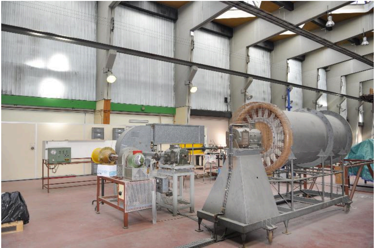
Vue de l'intérieur de la halle
