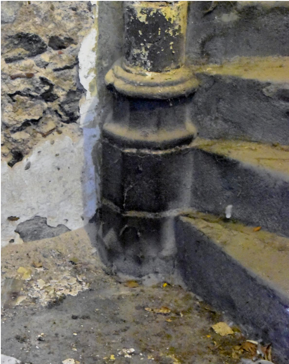
Escalier en vis : base du noyau
