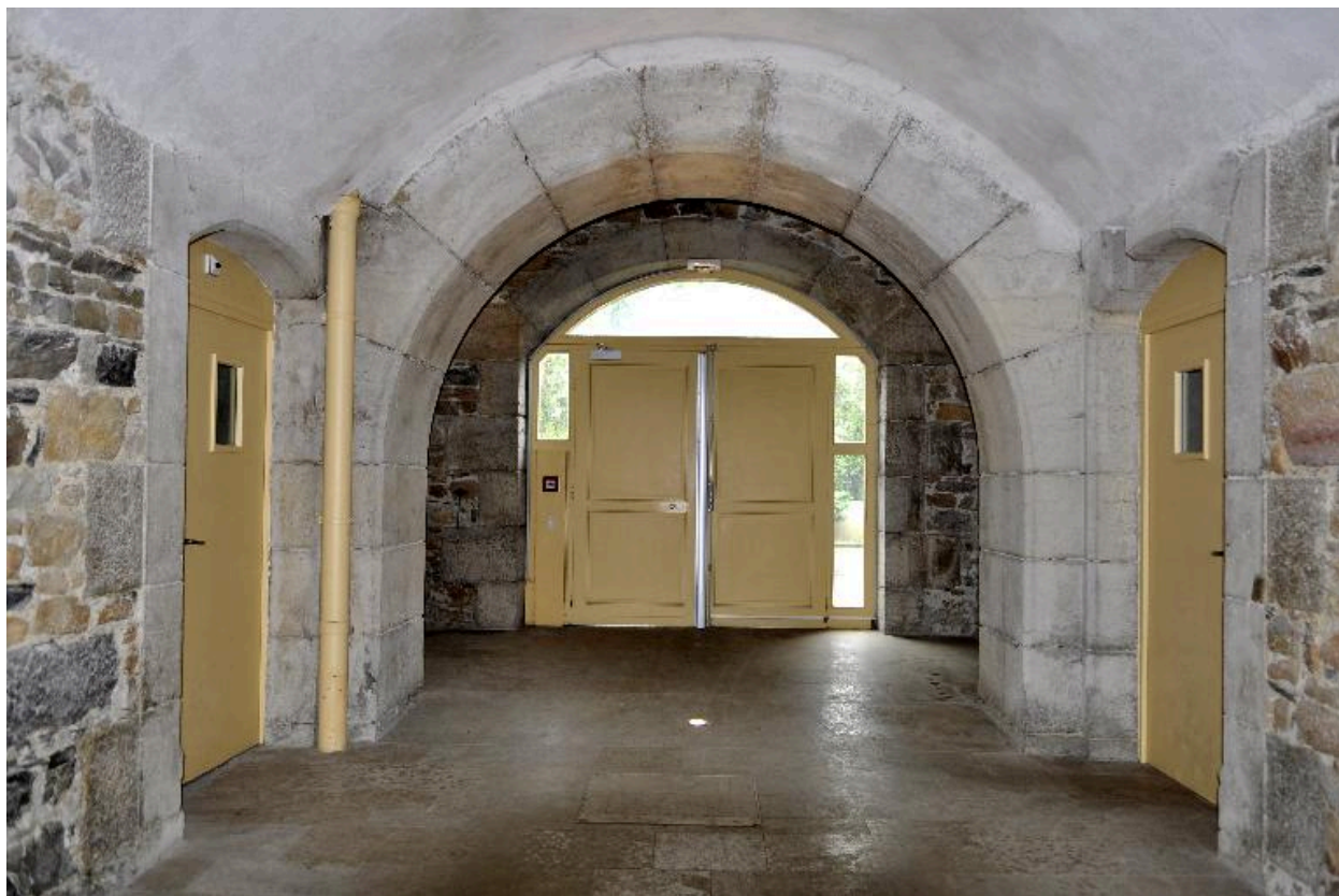
Corps de bâtiment nord-est, étage de soubassement : couloir d'accès aux caves, vers l'entrée
