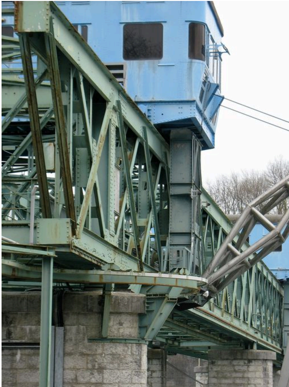
Barrage, vue partielle
