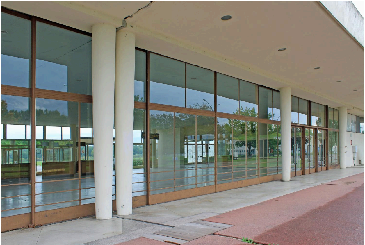
Détail de la façade ouest (côté ville) de l'aérogare de Vichy-Charmeil, au niveau du joint de dilatation transversal.
