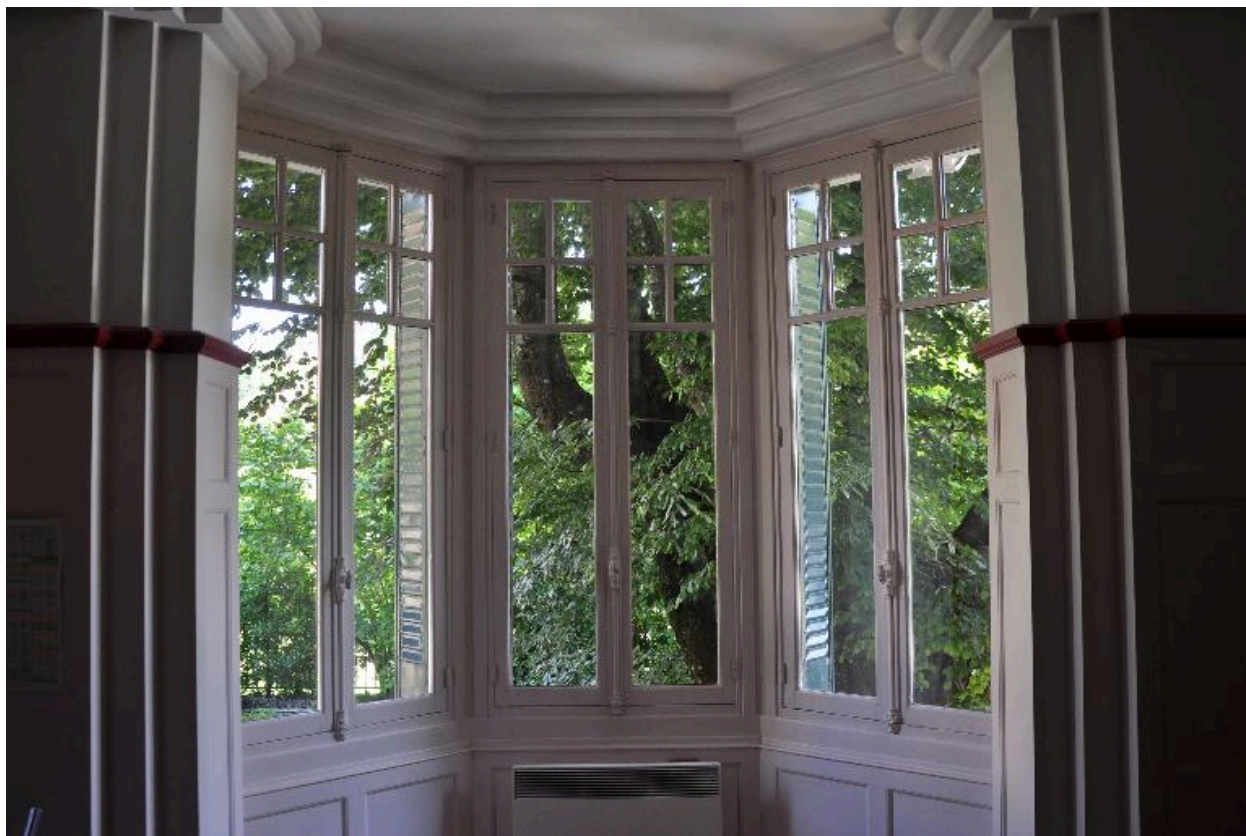
Bow-window depuis l'intérieur
