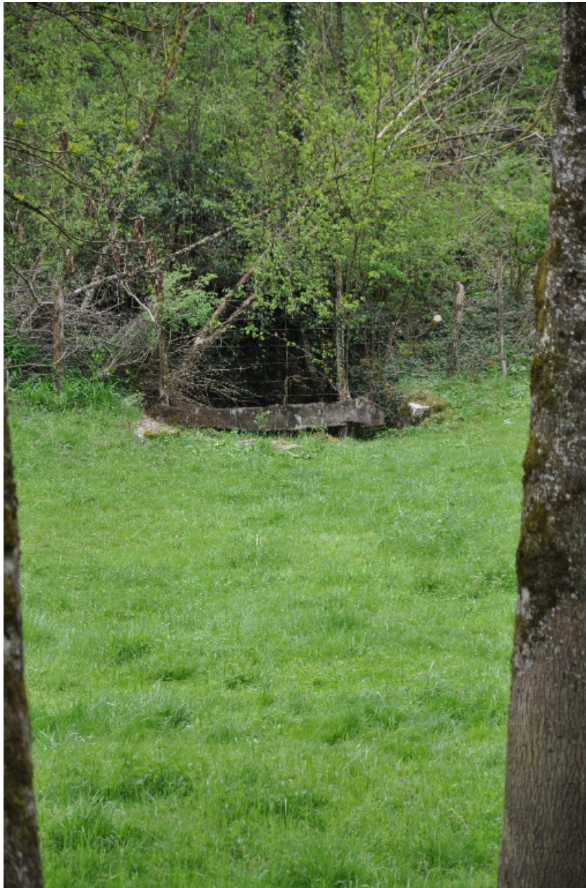
Vue de l'ancien canal de fuite du moulin en direction de la Deysse
