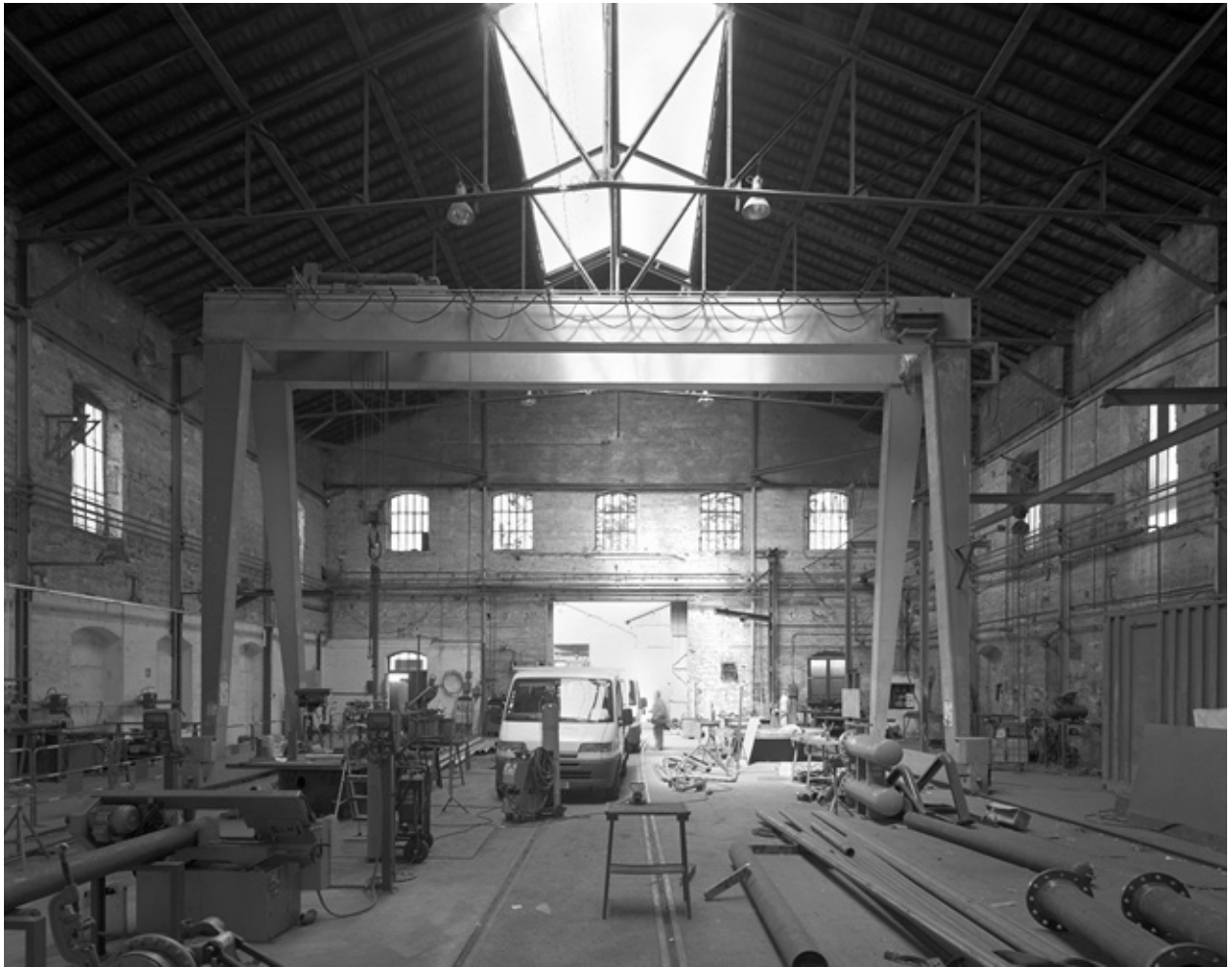
Fonderie vue sud
