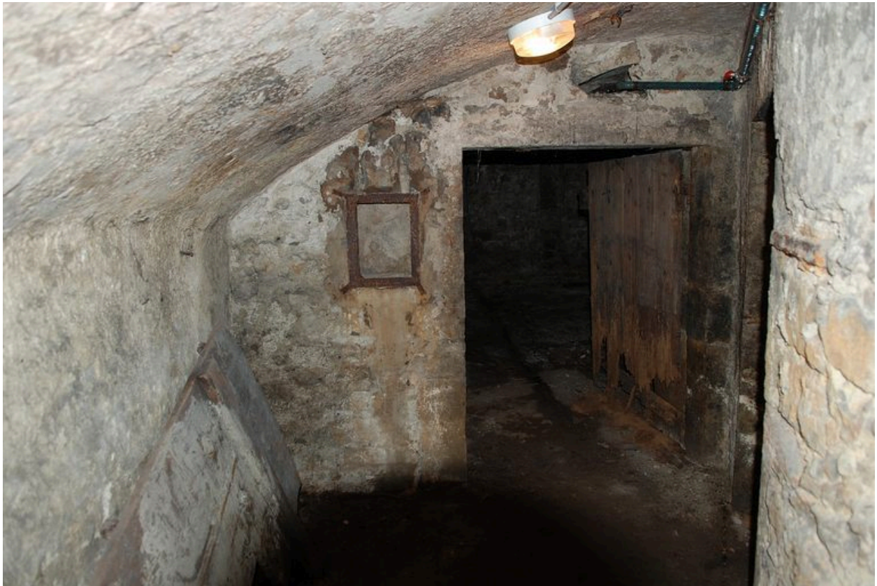
Vue partielle de la cave
