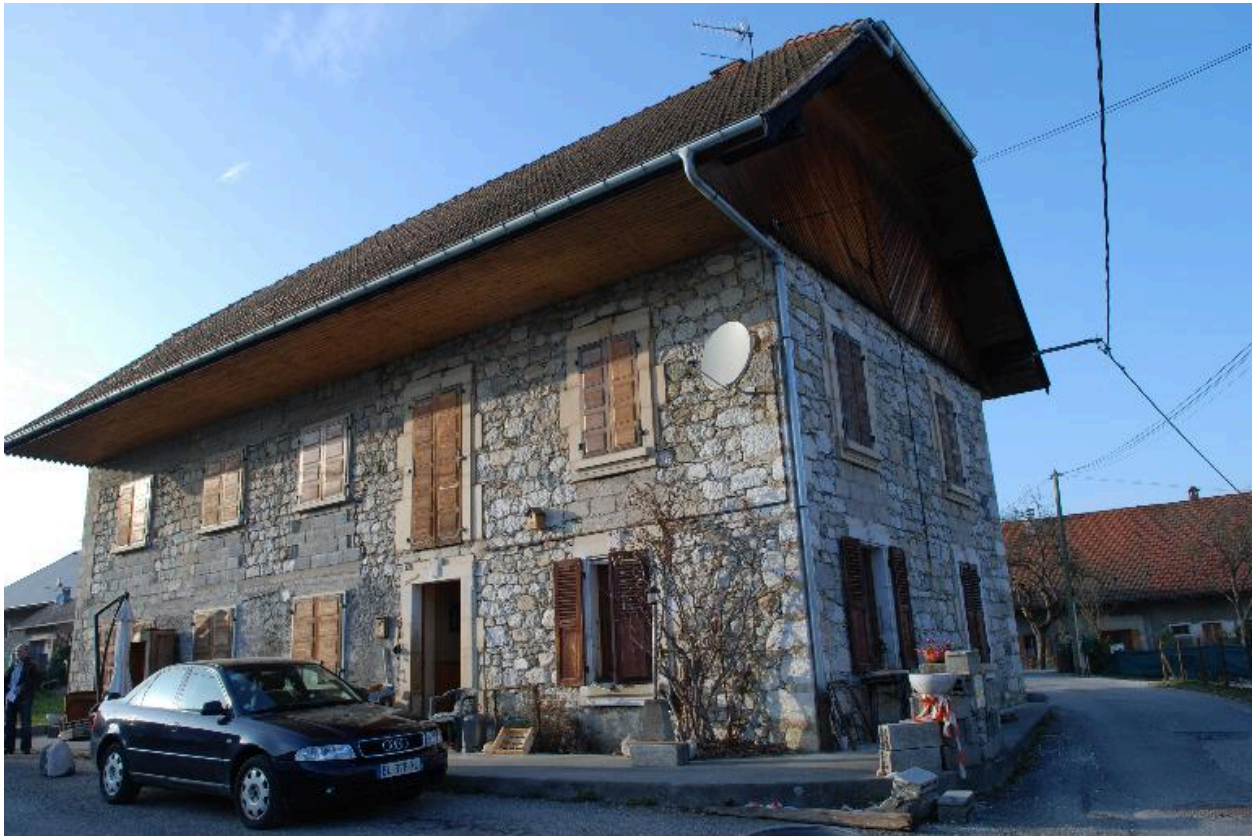
A3 282, Balevaz, maison. Vue d'ensemble de trois-quarts avant droit.
