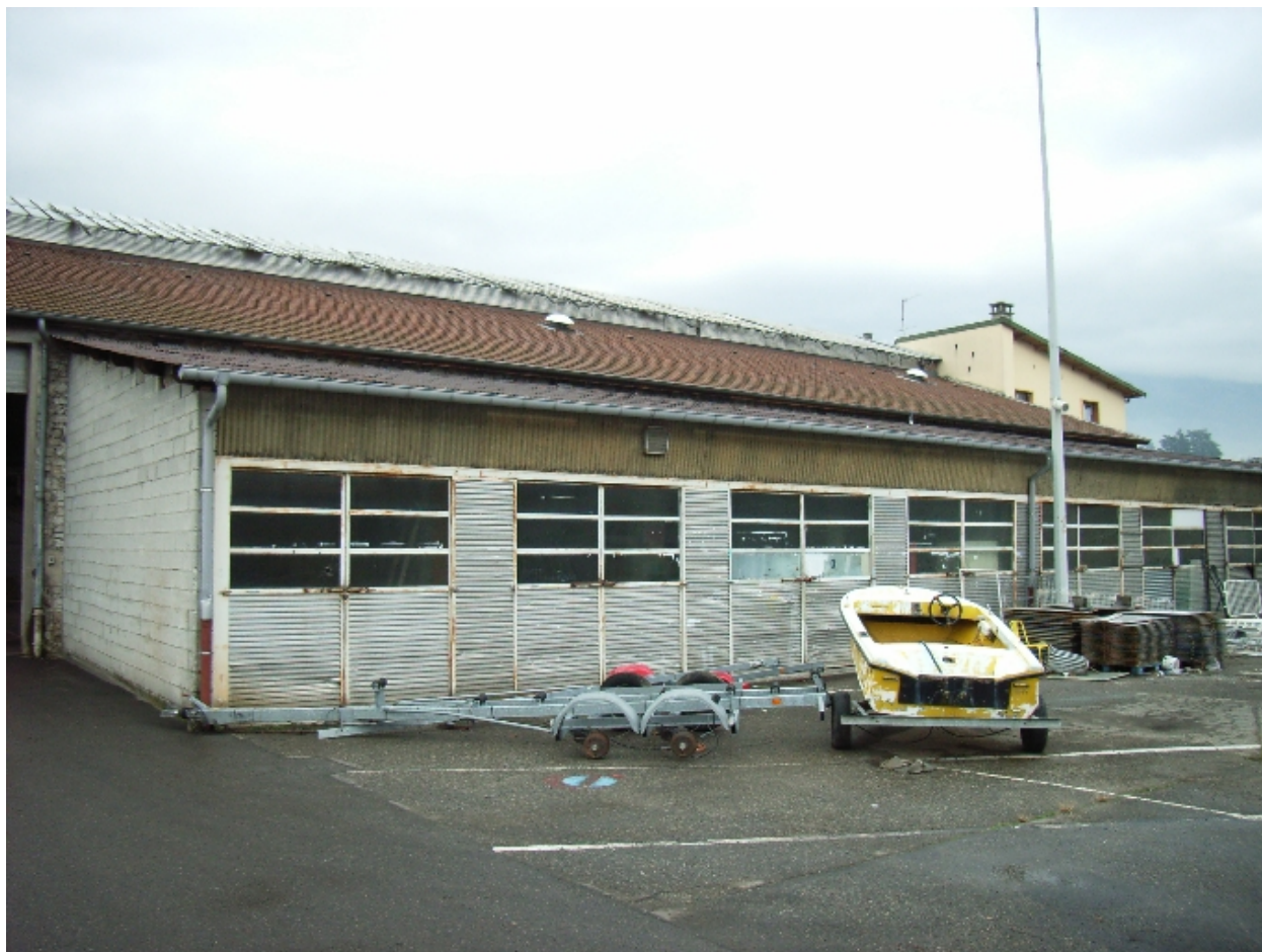
Bâtiment dans la cour postérieure
