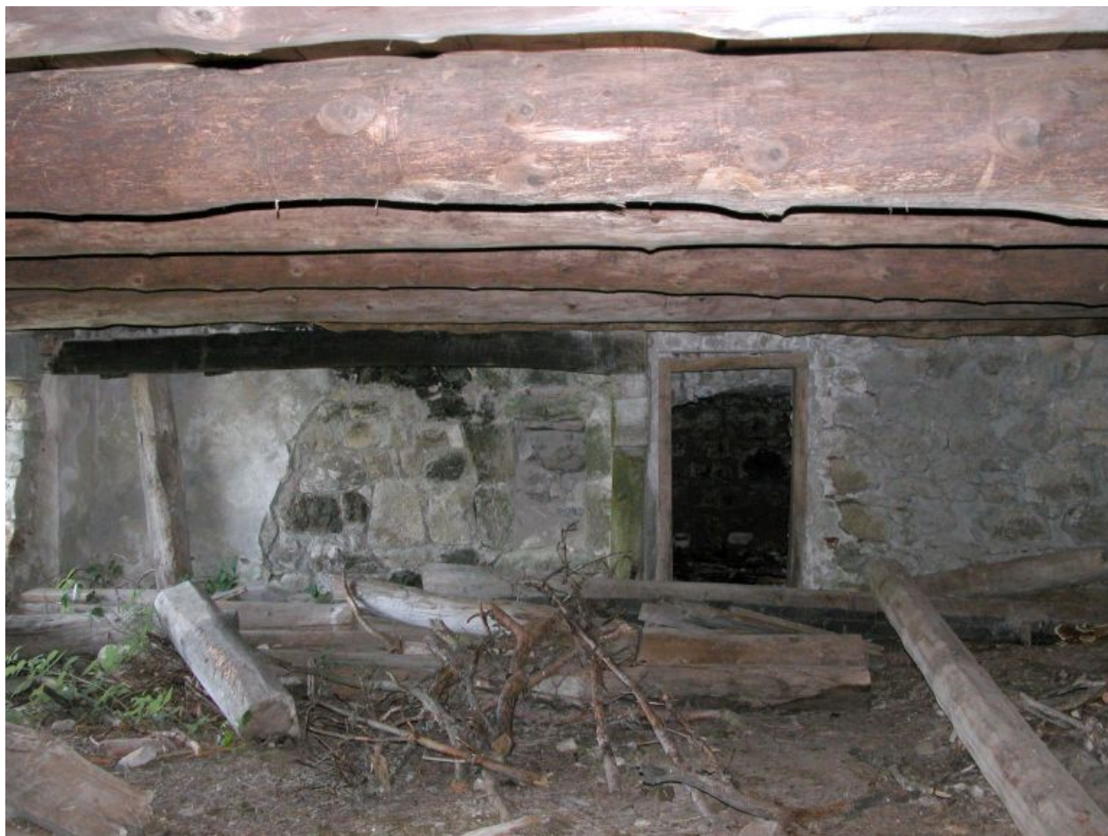
Vue intérieure de la cuisine. A gauche la cheminée, à droite l'entrée de la cave.
