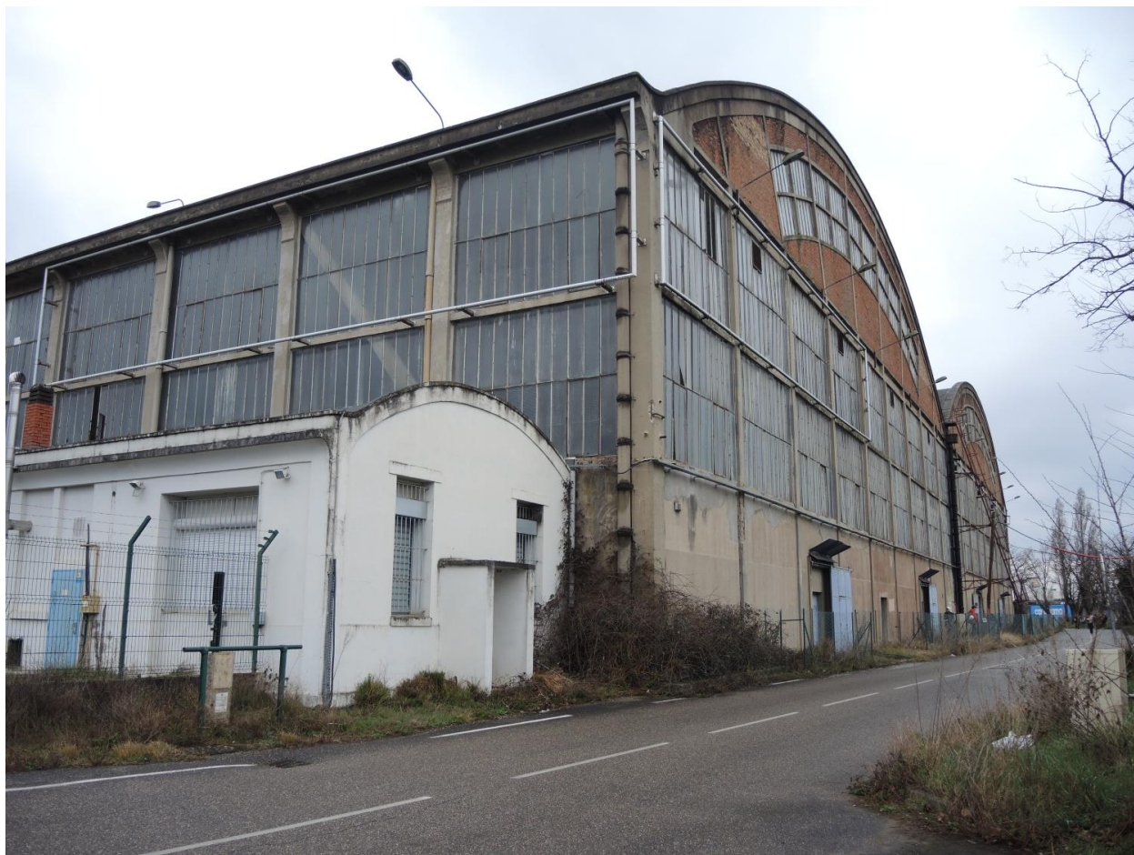
Hangar VI photo vue d'extérieur
