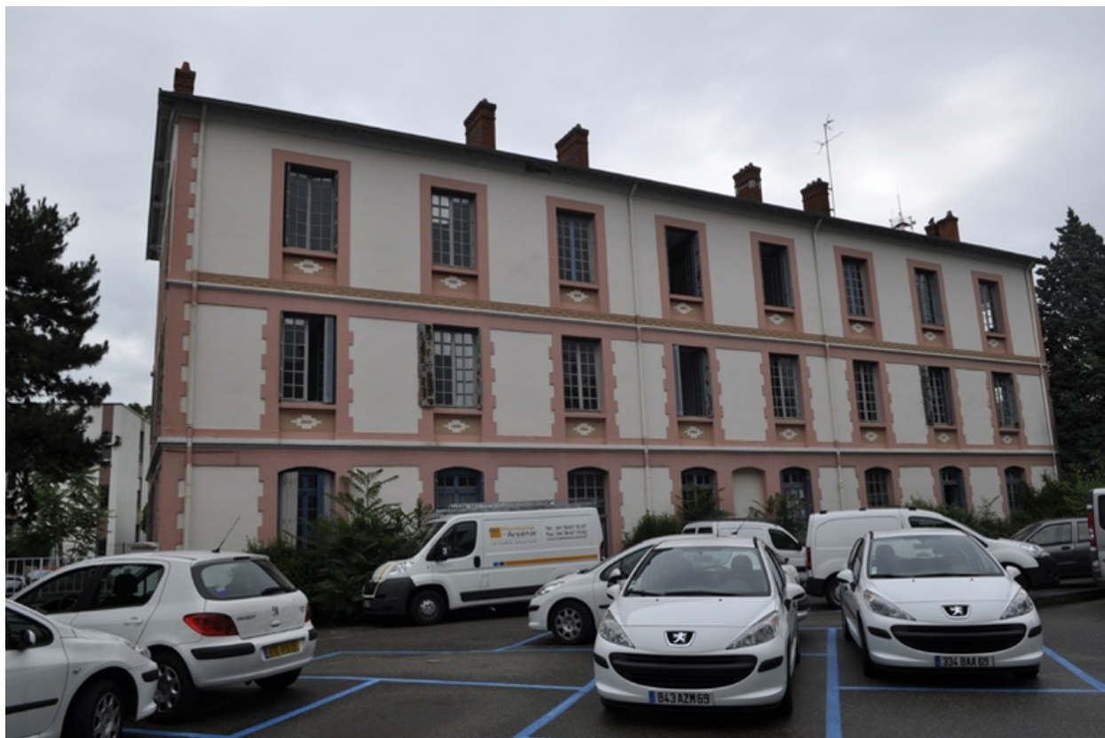
Bâtiment daté de 1912, façade ouest.
