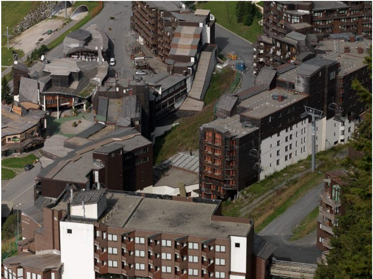
Vue depuis le sud-est
