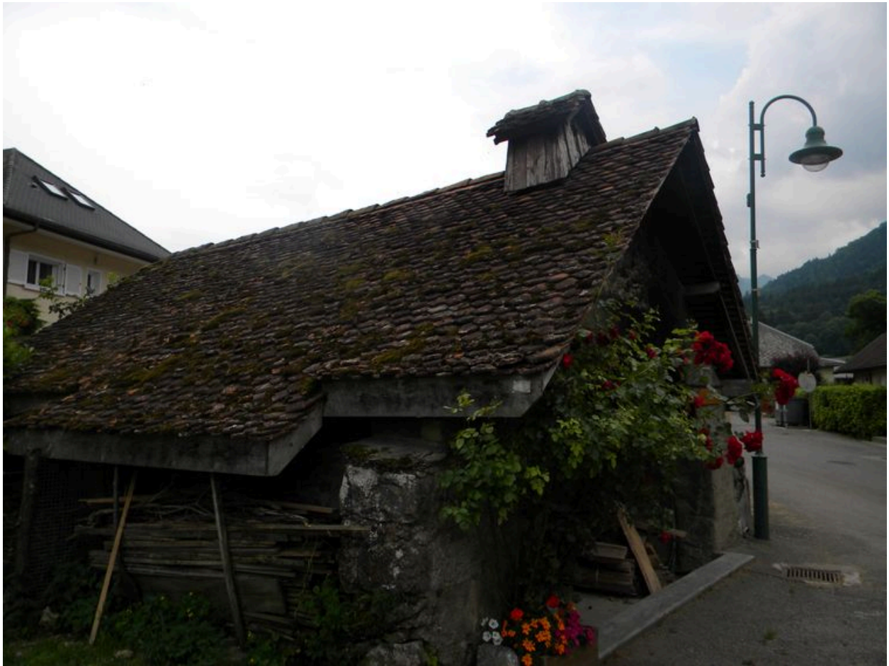
Vue latérale du four avant restauration.
