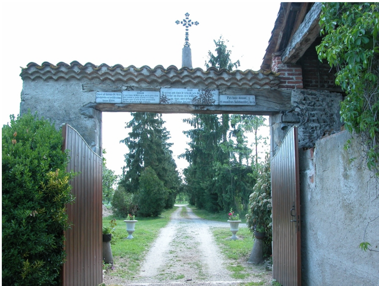
Vue du portail d'entrée, depuis le chemin.
