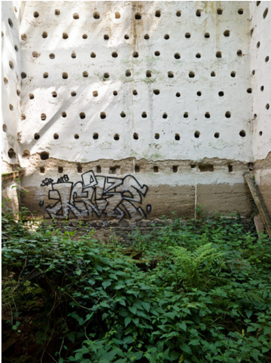
Vue intérieure : mur nord.
