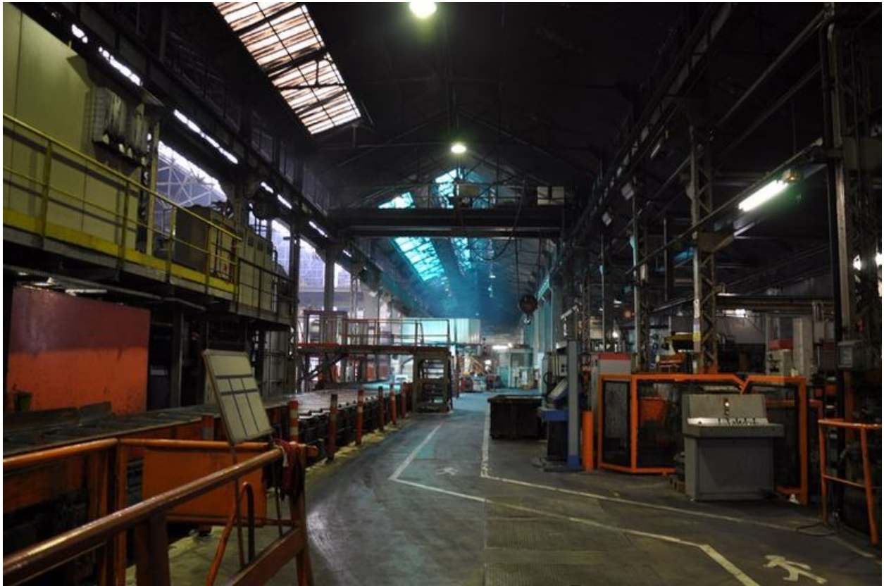
Entrée du bâtiment du laminage
