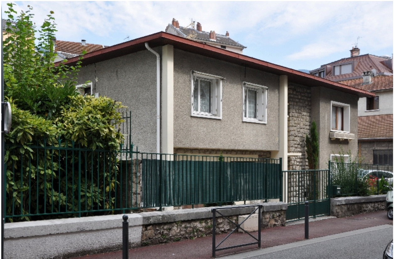
Façade postérieure sur rue
