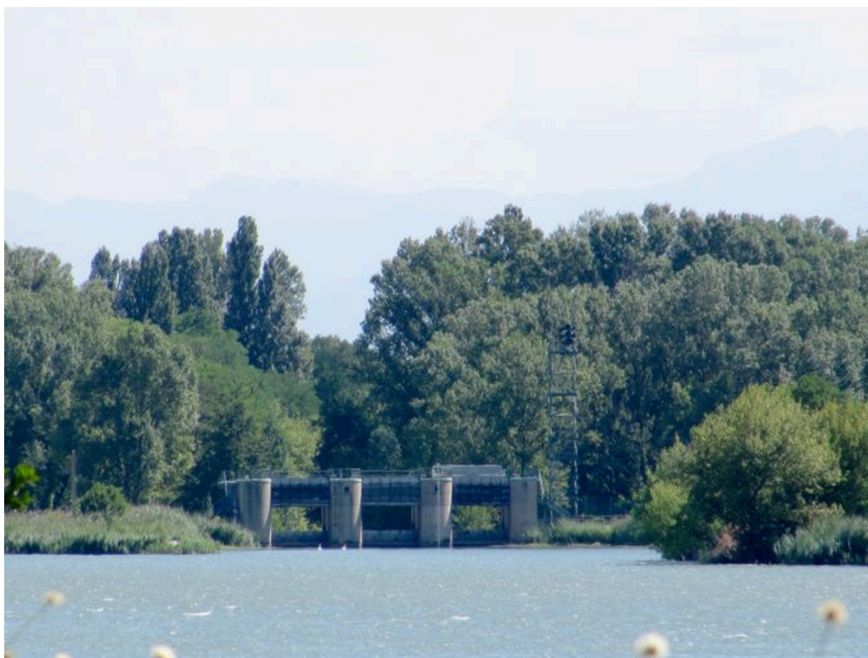
Vue générale face aval (depuis la R.N. 86 en rive droite)
