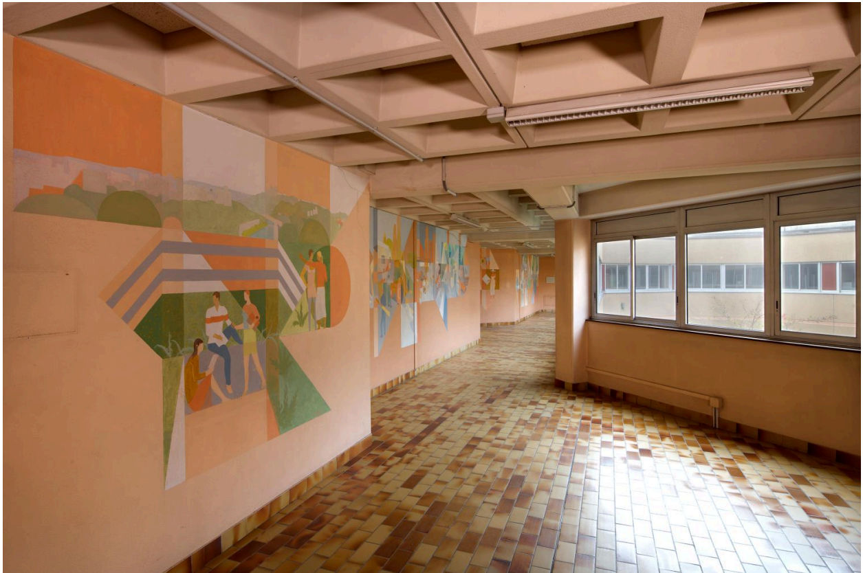
Vue d'ensemble de l'implantation des panneaux.
